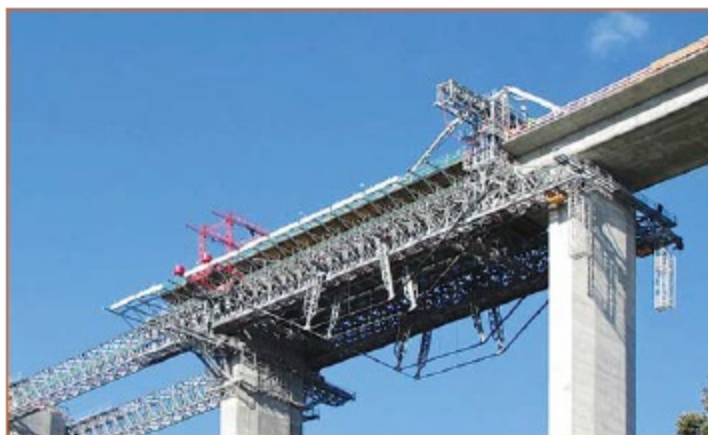
A atividade da BERD na construção de pontes baseia-se na aplicação do Sistema OPS (Sistema de Pré-esforço Orgânico), sendo uma solução exclusiva, patenteada em mais de 65 países.
