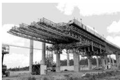
Perspectiva do cimbre autolancável em obra, no Vale do Sousa
